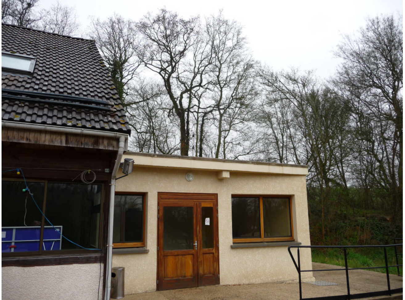
Figure 37 : Installation de la station de mesurage sonore à Rosoy en Multien
