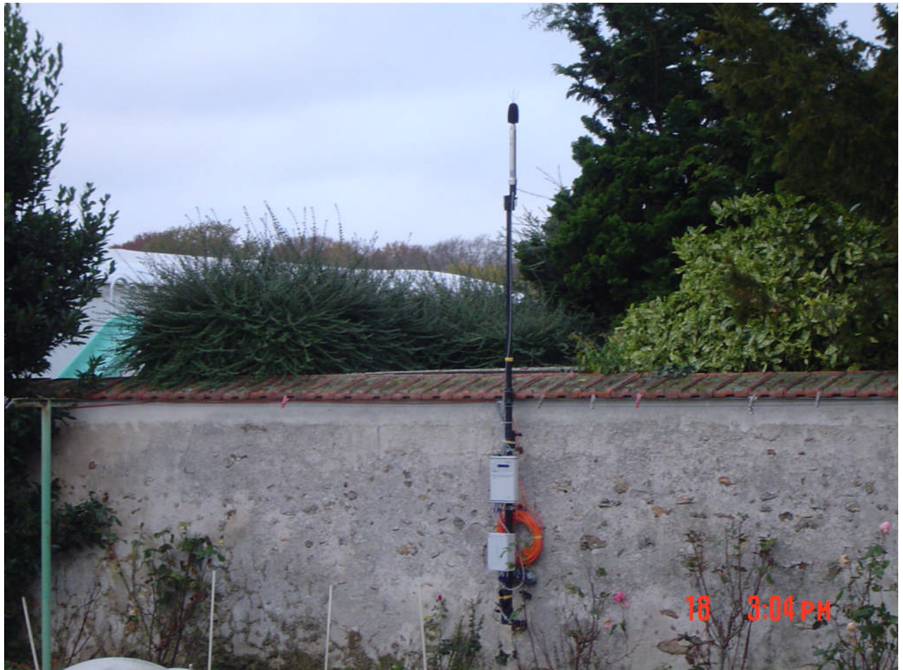
Figure 47 : Installation de la station de mesure sonore au Fayet
